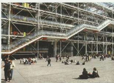
Le Centre Pompidou
